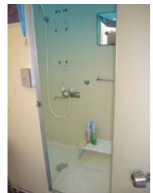
コンテナシャワー (5)
