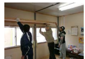
棚の取り付け
