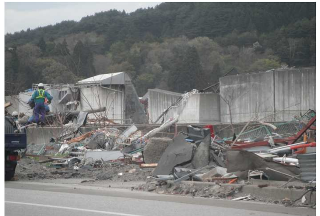
大槌町の防潮堤 岸壁の反対側、市街地よりに建てられた防潮堤(高さ5m以上)も簡単に破壊してしまう威力。
