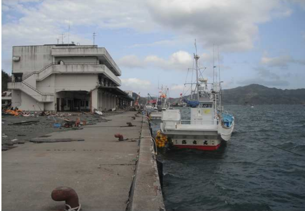
大槌町の岸壁 左の建物は漁協事務所。三階建ての建物の屋上を超える津波が襲っている。
