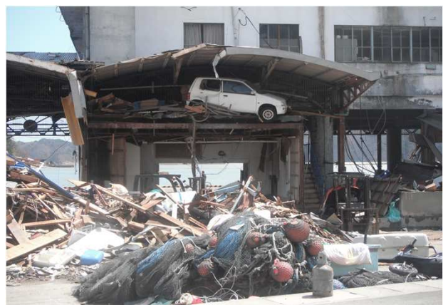
宮古市の漁港 引き波で自動車が通路の屋根部分に引っかかっている。この通路も大型トラックが通るため3.5m以上の高さがあるが。
