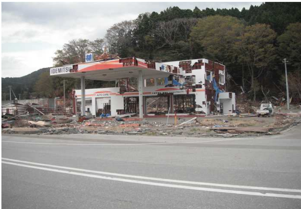
大槌町の岸壁 岸壁の反対側にあるガソリンスタンド。壁や建物の中のものが全て流され、柱だけの状態に。
