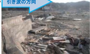
ダメージを受けた堤防が、がれきを含み、勢いを増した引き波でとどめを刺され、破壊されたことを示すのが③の写真。
