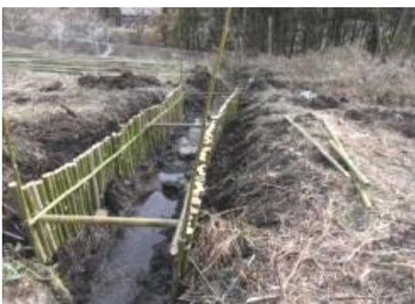
3 水平方向に竹を置き、さらにそれを押さえる棒をかませ、竹の壁(土砂)が崩れてくるのを防ぎます。
